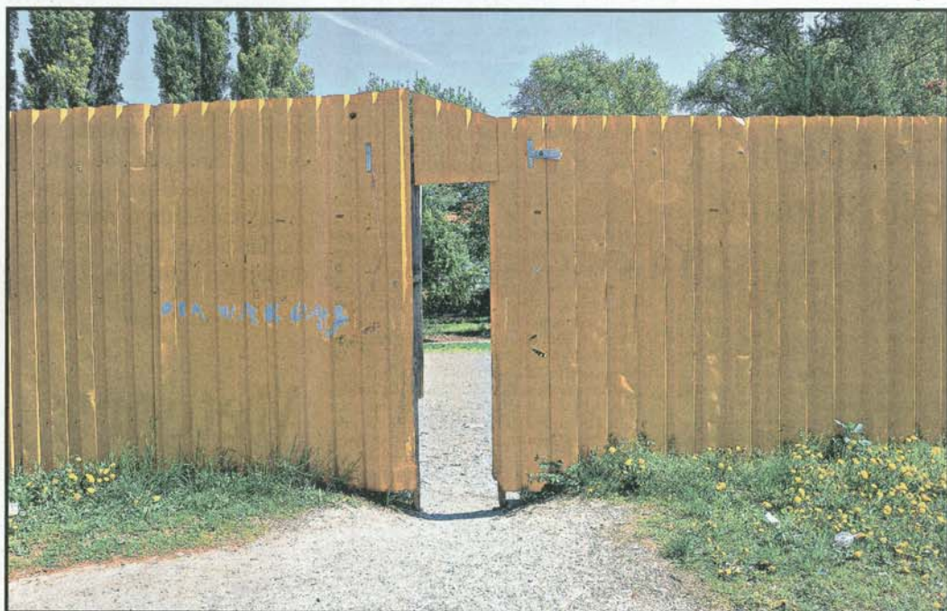
Ein Spalt, breit genug, einen Menschen durchzulassen, zu schmal für einen Einkaufswagen. Macondo, Wien-Simmering. [Foto: Arquitectos]
